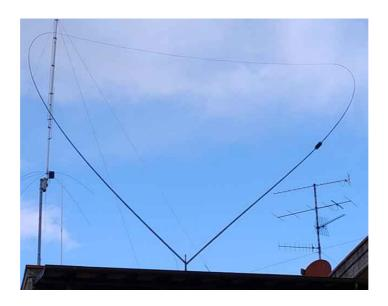
Ancorché la forma ricordi molto una antenna delta loop, in realtà è una "verticale" ripiegata lunga quasi 20 mt (19,6 mt per l'esattezza), che è portata in risonanza grazie ad una bobina di circa 250 uH posta a 16,25 mt dalla "base".
