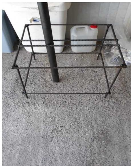
Nella gabbia sono stati fissati i montanti che costituiranno la base di appoggio del palo e il fulcro di rotazione dello stesso
