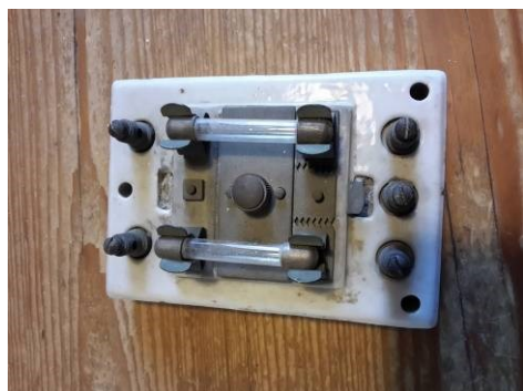
Il mitico Stipel telefonico in ceramica con scaricatore a punte (chissà di che epoca)
