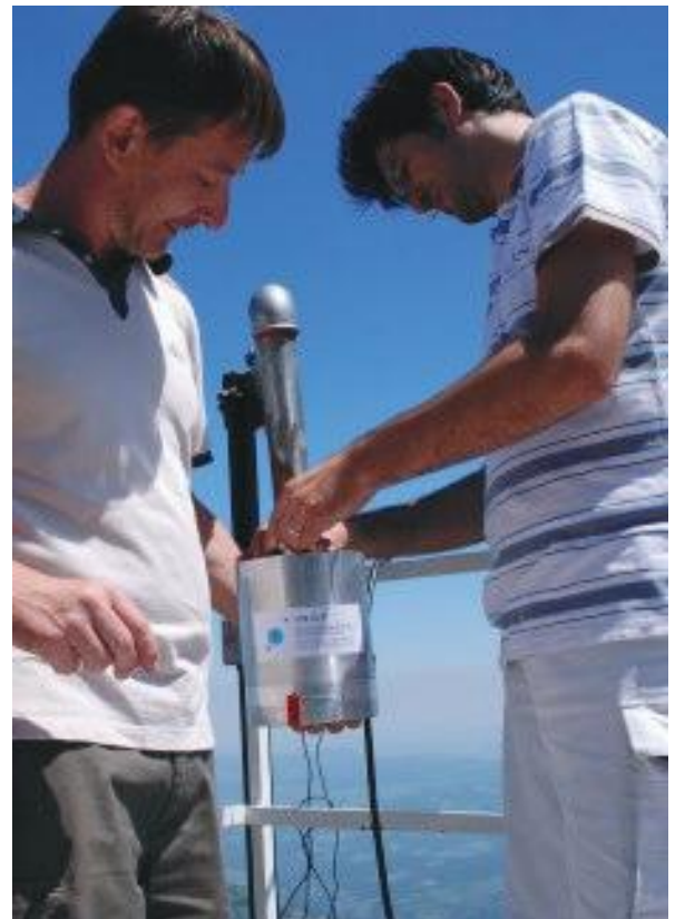
Installazione di un sensore EFM sulla vetta del Monte Cimone
